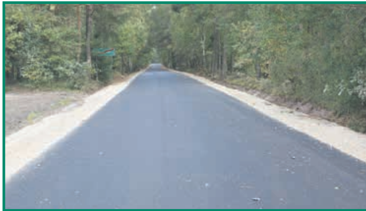
Przebudowa drogi w Starej Ciświcy - efekt końcowy
