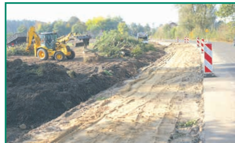
Budowa chodnika na odcinku Lipice-Grodziec - etap I
