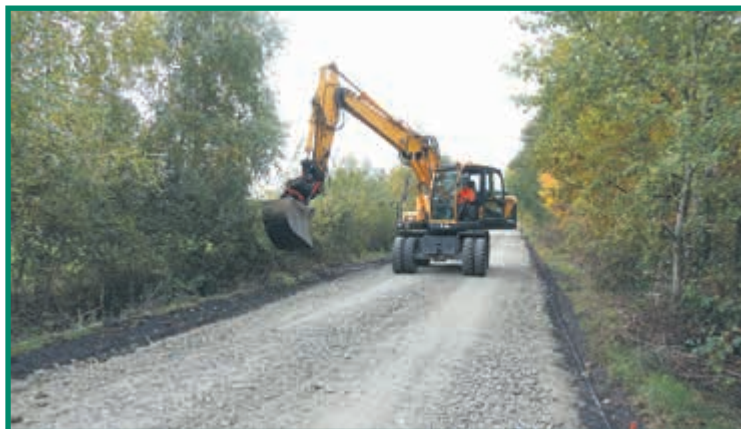
Przebudowa drogi Lipice-Nowa Huta, Nowa Huta-Junno, Stara Huta-Mokre
