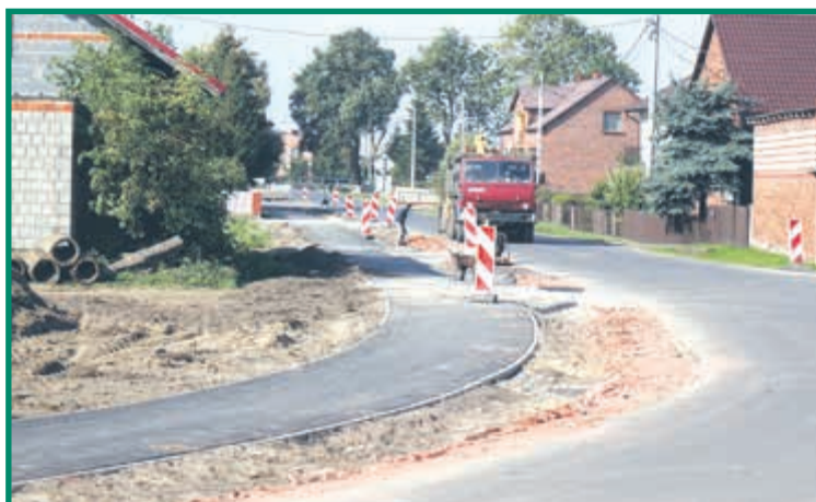
Budowa chodnika w Łągiewnikach
