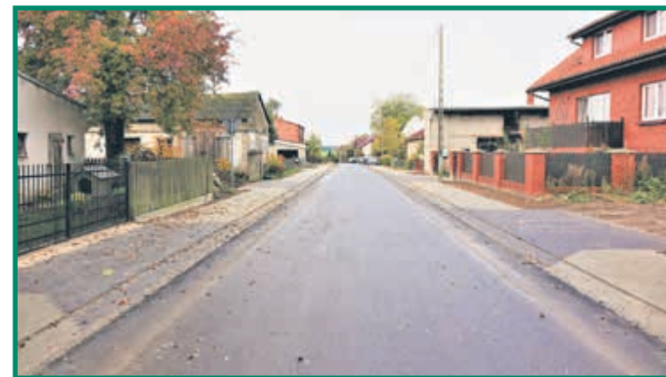
Przebudowa drogi w Białej - efekt końcowy
